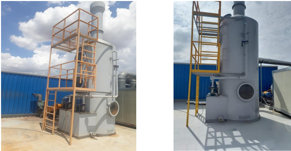
Hình 3.10 Hình ảnh của hệ thống xử lý khí thải từ quá trình sấy sau tẩy rửa bề mặt
