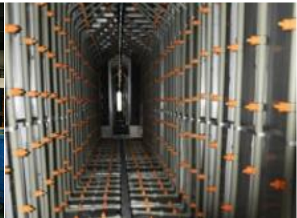
Xử lý bề mặt sử dụng béc-phun
